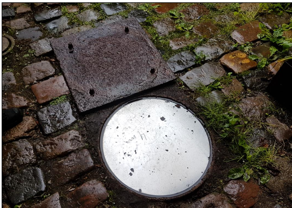
Figur 5-3. Tætning af brønddæksel i forbindelse med gennemførelse af ventilationsforsøg.
