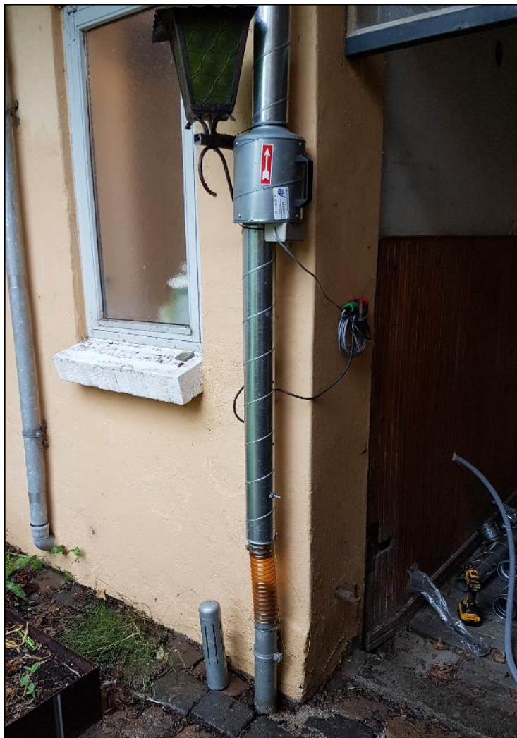
Figur 5-2. Montering af ventilator på luftindtag L3 til samlebrønd BR1.
